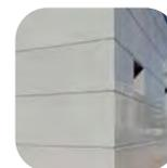
Contrairement à la pierre naturelle, le marbre technologique COMPAC est homogène. Il peut être posé sur de grandes surfaces sans qu'aucun joint ni aucune différence de teinte ne soient appréciables.
